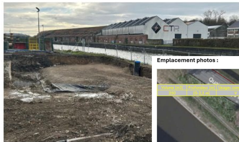
Zone de terrassement
